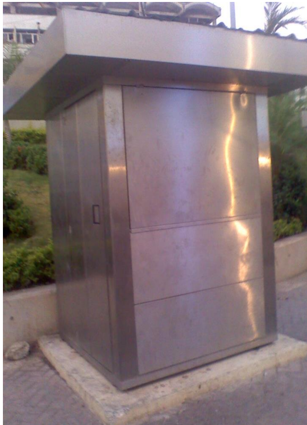
Fotografía 10. Prototipo de caseta para venta de productos.
