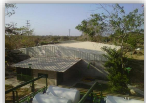
Ilustración 7. Unidad de almacenamiento
