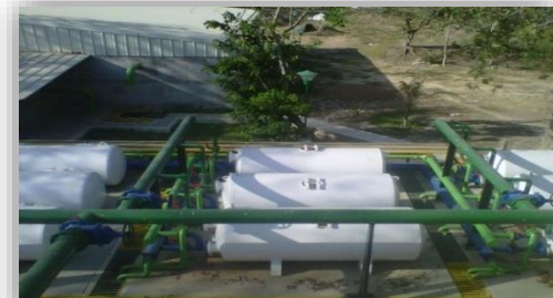
Ilustración 5. Filtros horizontales a presión
