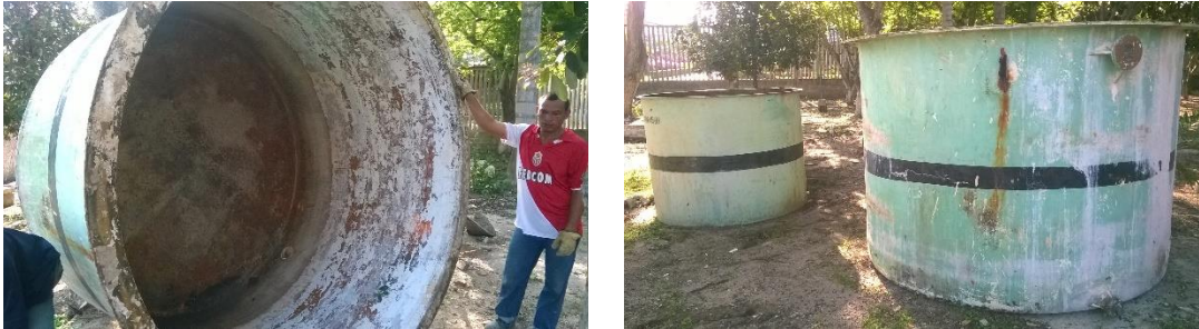
Imagen 11. Vista de los tanques para la decantación de los lodos.
