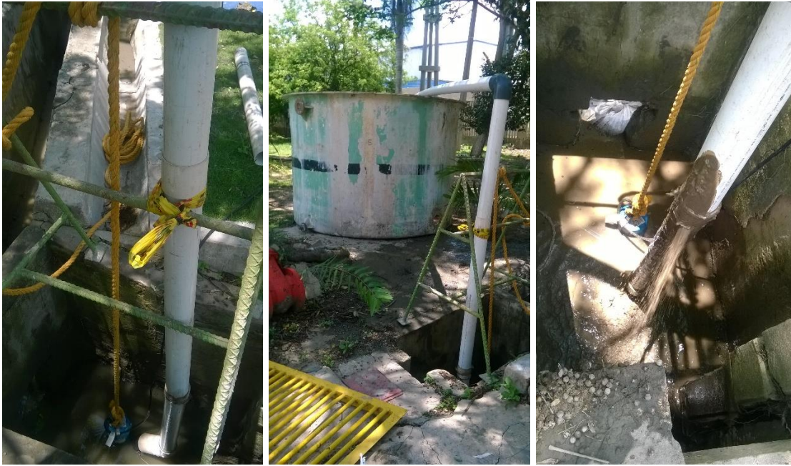
Imagen 9. Montaje del sistema de drenaje compuesto por bomba, adaptadores, válvulas, etc.
