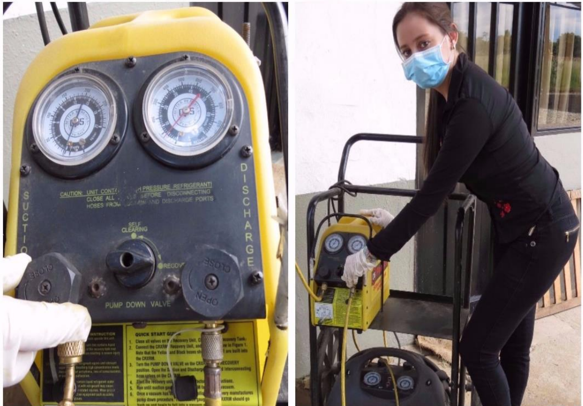
Figura 11: Cierre de válvulas
