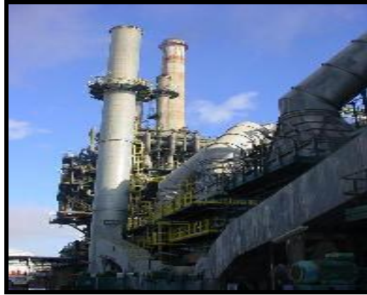
Figura 6. Planta de producción fabricación de cemento.
