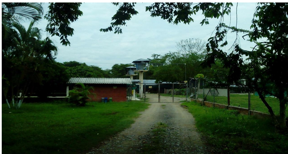
Figura 24: Vista de acceso a la zona de producción, se observa los tanques de almacenamiento de agua para los bebederos de los seis galpones.
