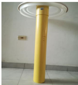
Figura 32. Instalación retal tubo PVC Ø 4". "Elaboración propia".
