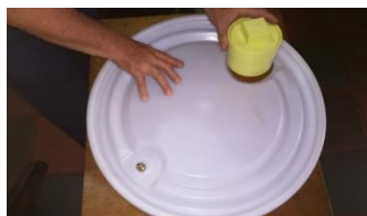
Figura 31. Instalación tapón roscado PVC Ø 4". "Elaboración propia".
