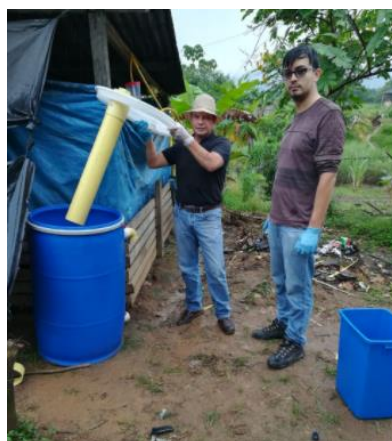
Figura 40. Sellado hermético del biodigestor. "Elaboración propia".
