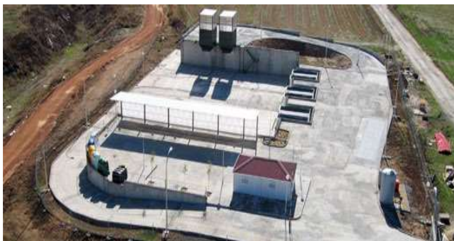
Fotografía 1 - Estación de Transferencia de Residuos Urbanos en El Casar, Guadalajara - México. Fuente: Internet http://www.grupoortiz.com/inditec/es/areas-de-actividad/residuos/proyecto-id-617/
