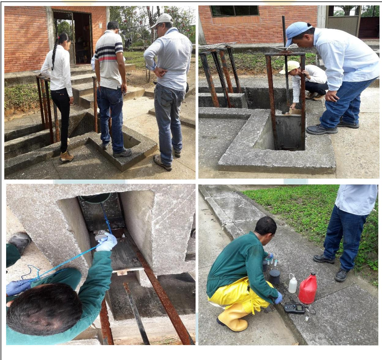
Figura 8. Caracterización de aguas residuales de la PTAR del Centro Poblado de San Isidro de Chichimene.
