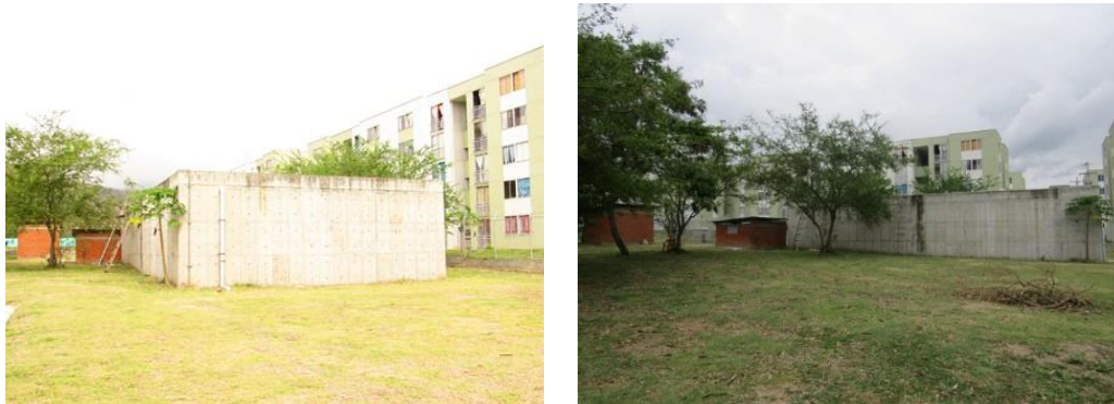
Figura 8 Tanque de almacenamiento lado Frontal y lateral
