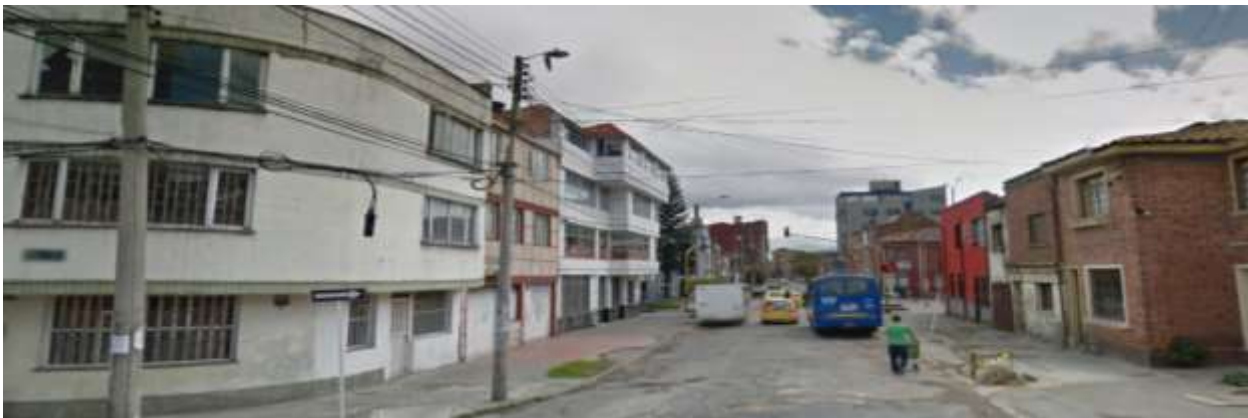
Deterioro de malla vial por mas de 10 años - Carrera 20 calle 45
