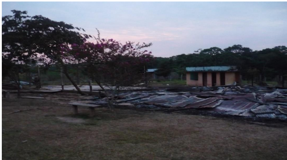
Figura 6. Ruinas de la Institución Educativa Rural Villa Carmona (I. E. R. VILLA CARMONA – PEI. 2017).
