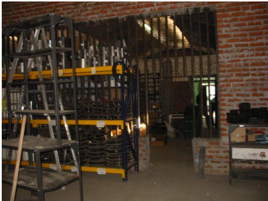
Puerta que comunica Bodega No. 1 y Bodega No. 2
