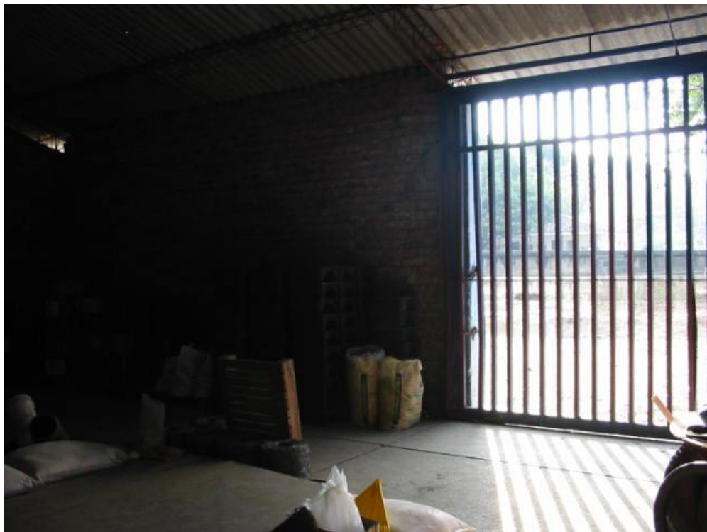
Puerta de acceso a Bodega No. 2
