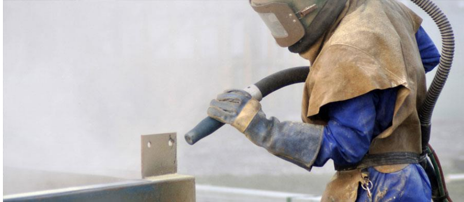
Imagen 5. Aplicación de Sandblásting en SEMITEC S.A.S.
