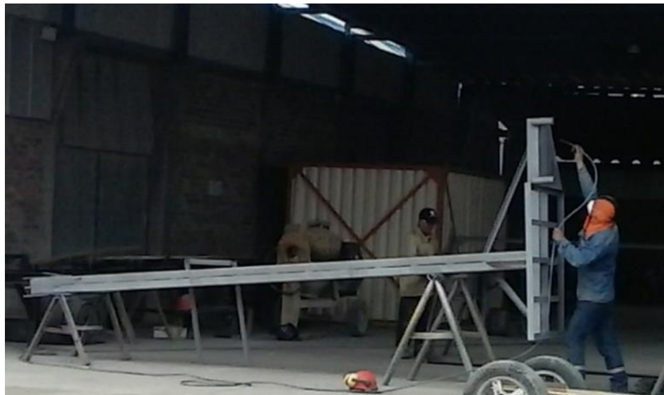
Imagen 6. Limpieza de la estructura con aire a presión en la bodega de Pintura en SEMITEC S.A.S
