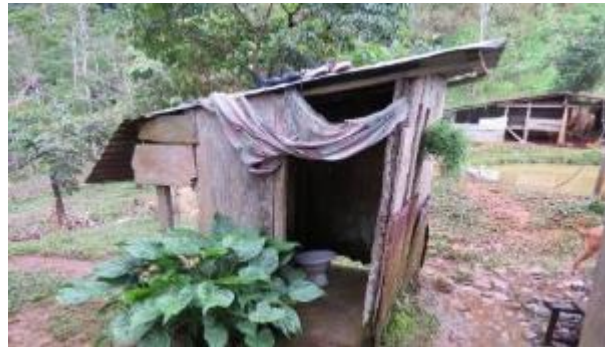
Foto 2. Batería sanitaria, tipo taza campesina. (Fuente PNN AFIW)
