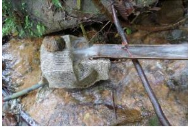
Foto 9. Bocatoma Artesanal. (Fuente PNN AFIW)
