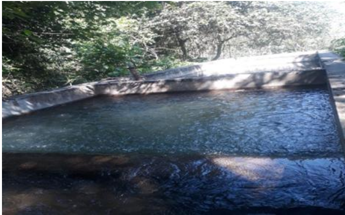
Fotografía 1. Desarenador del Acueducto. Acueducto Fuente: Los autores
