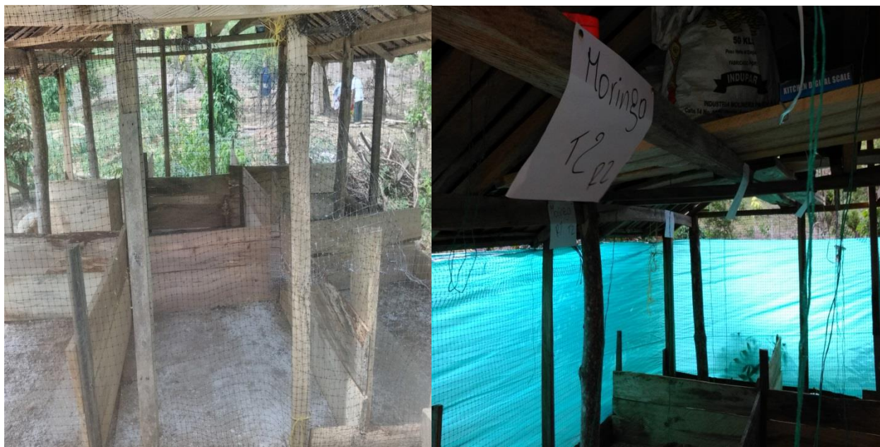
Anexos 6. Infraestructura (galpón).
