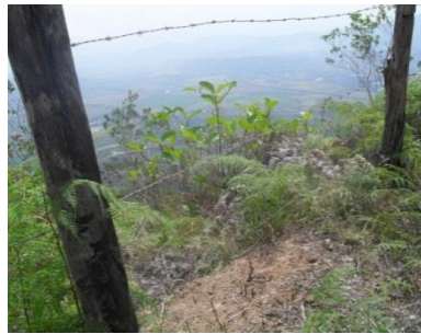
Ilustración 26 Cerca de aislamiento sin mantenimiento
