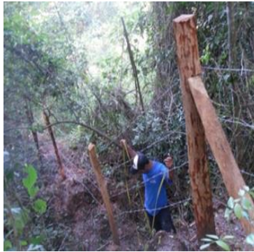
Ilustración 40 Medición de la cerca de aislamiento predio potreros
