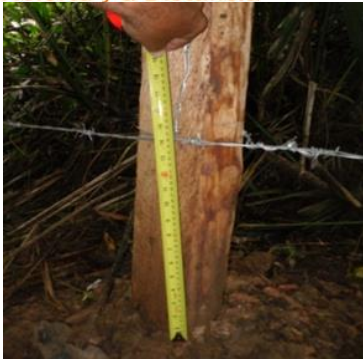
Ilustración 39 Medición entre hilos de alambre colocados
