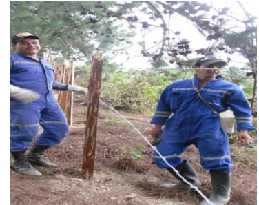
Ilustración 53 Trabajadores en el mantenimiento d la cerca de aislamiento
