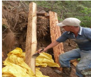
Ilustración 52 Inmunización de estantillos con caucho para evitar derrames al suelo
