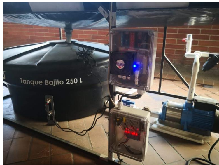
Fotografía 15. Instalación de los tableros de control y sensores
