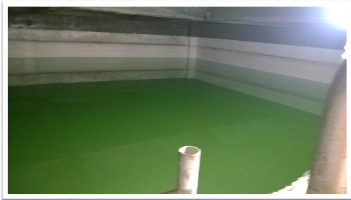
Fotografía 5 Tanque Limpio y Desinfectado
