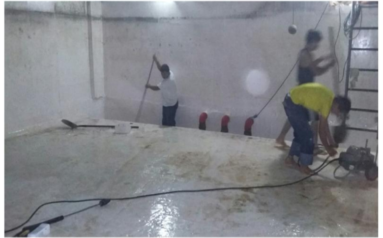
Fotografía 3 Mantenimiento del Tanque de Almacenamiento
