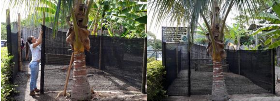
Figura 7. Adecuación del sitio.
