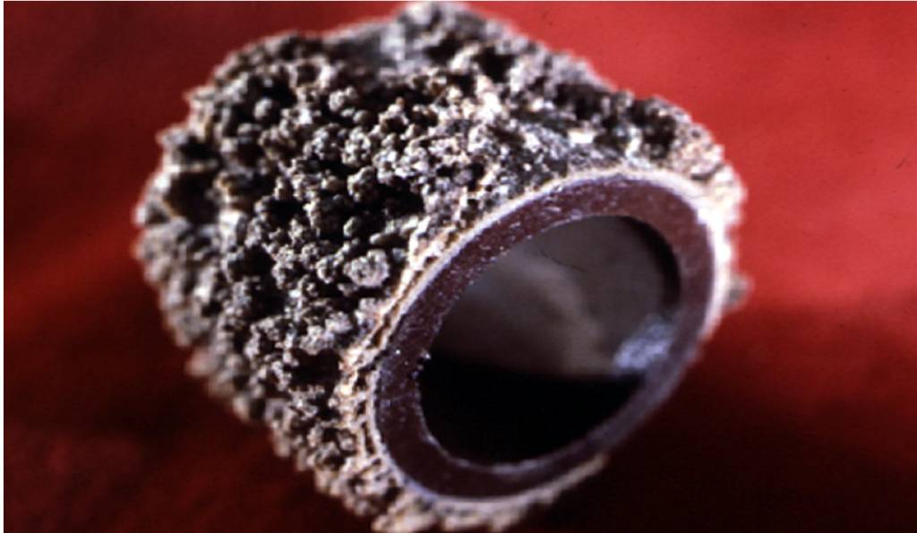
Figura 21. Incrustación parte externa de una tubería
