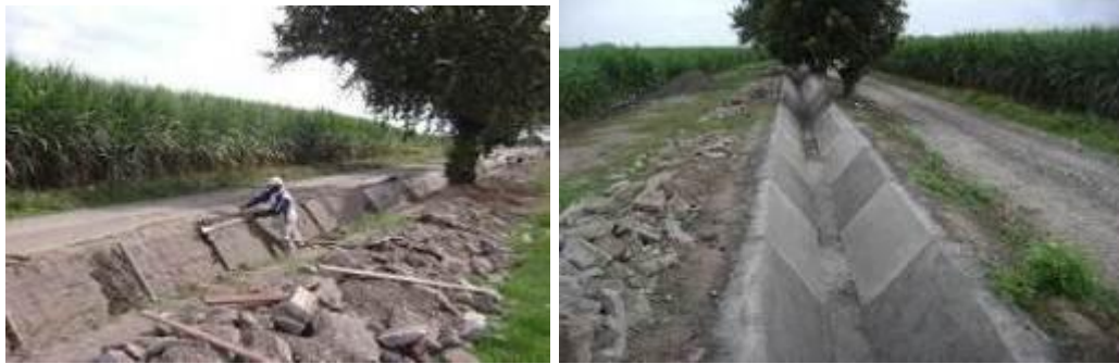
Fig. 2, 3 Arreglo de canales revestidos (antes y después).
