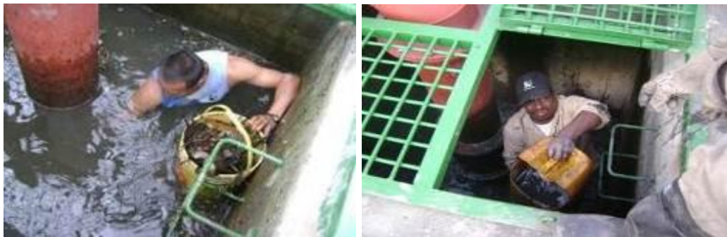
Fig. 4, 5 Limpieza de la granada del rebombes donde llega hojarasca y lodo, evitando que llegue al impulsor y se tape evitando el buen flujo de caudal.
