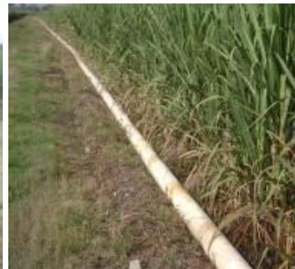
18. Tubería de ventanas
