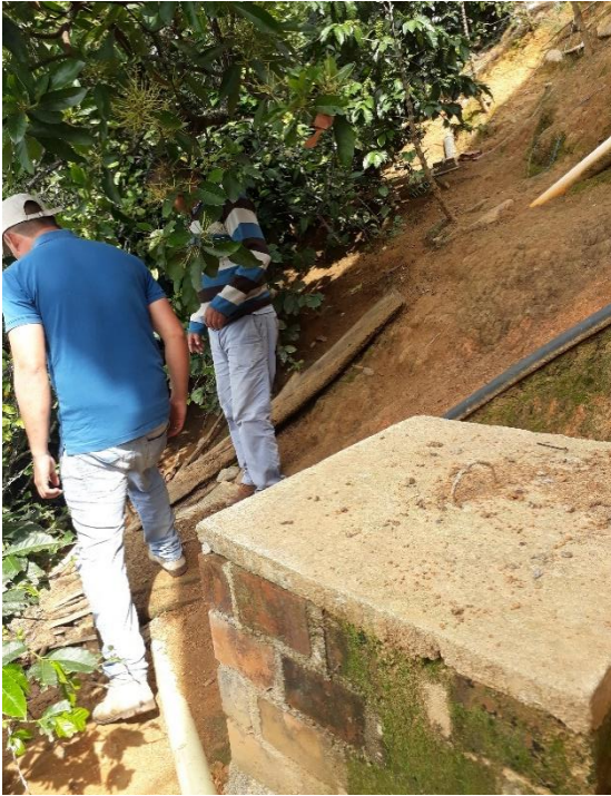
Fotografía tomada por: Francy Castillo Tratamiento de aguas residuales
