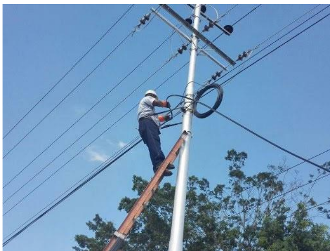
Figura 11. Lineo realizando el tendido de fibra (sylcomteldataperu, 2022)
