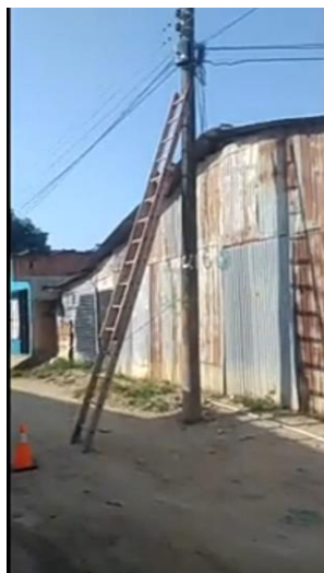
Figura 14. Caja NAP de segundo nivel, fuente propia.
