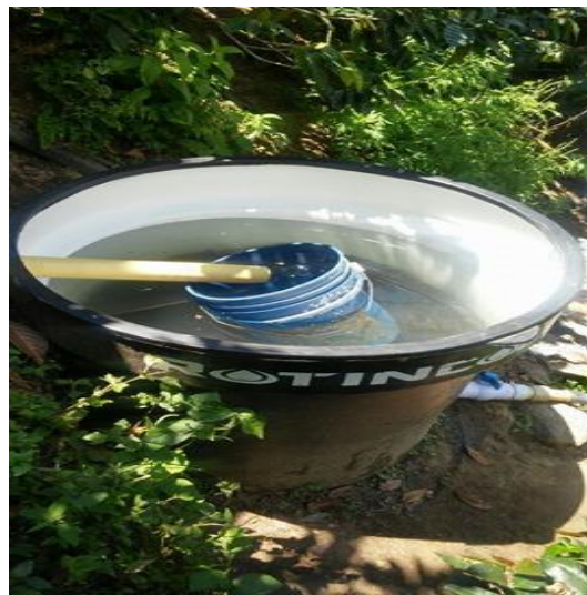
Fig. 17. Prueba de descarga del filtro Fuente: El Autor
