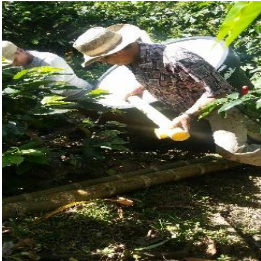
Fig. 34. Corte de tubo pvc 2'' Fuente: El Autor
