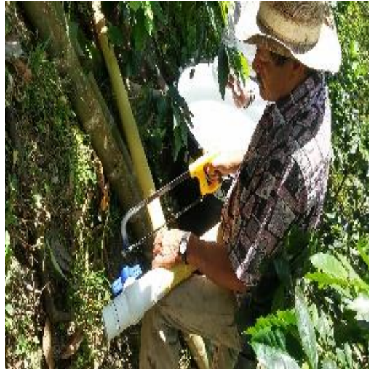
Fig. 35. Instalación llave de paso Fuente: El Autor
