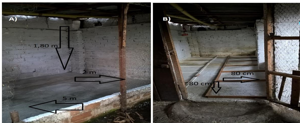
Figura 5. Establecimientos lugar del experimento. A) Adecuación de espacio y B) Diseño pilas de compostaje.
