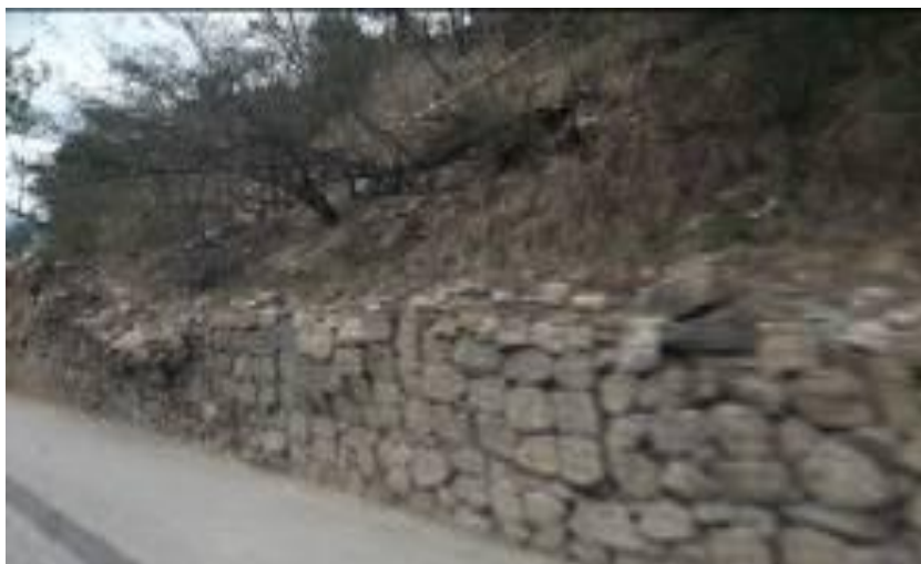
Foto 7. Obra de mitigación del riesgo
