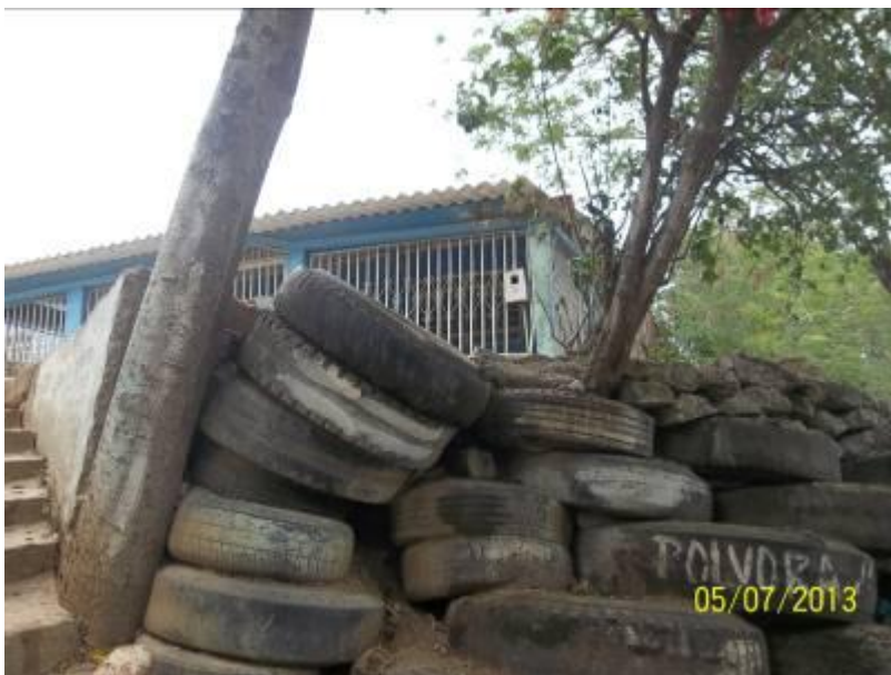
Foto 5. Adecuación de soporte con llantas para evitar el deslizamiento
