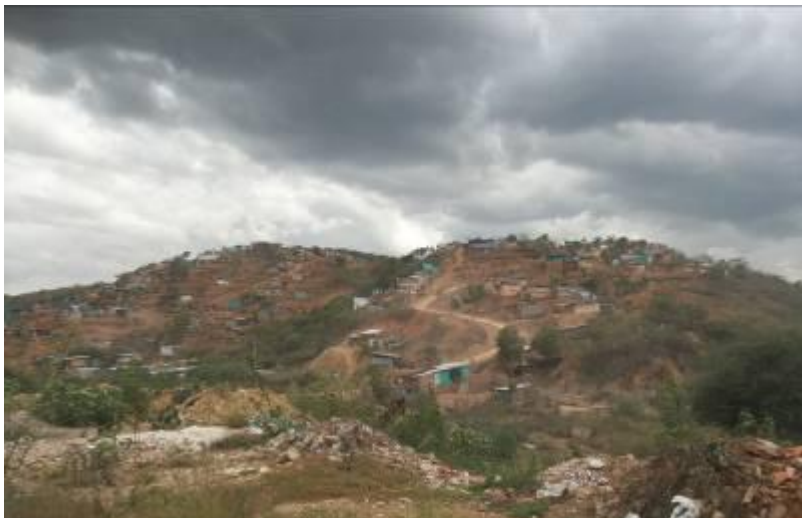
Foto 3. Vista general de viviendas en zona de deslizamiento
