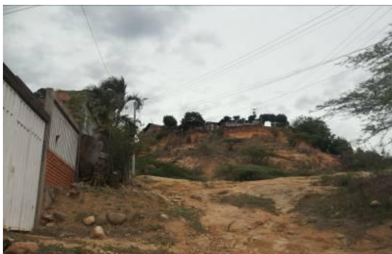
Foto 10. Afectación del terreno por deslizamientos
