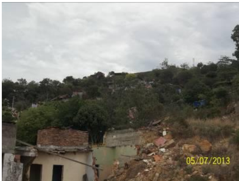
Foto 9. Zona de Muy alto riesgo de deslizamiento
