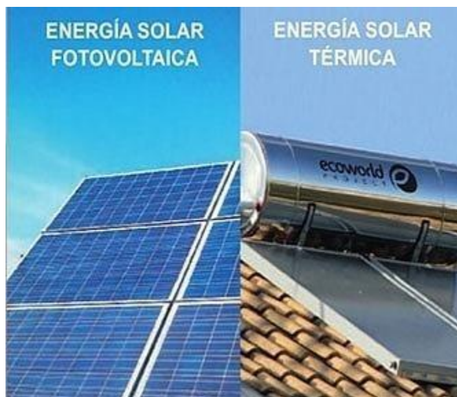
Figura 2 Diferencia entre sistema solar fotovoltaico y solar térmico
