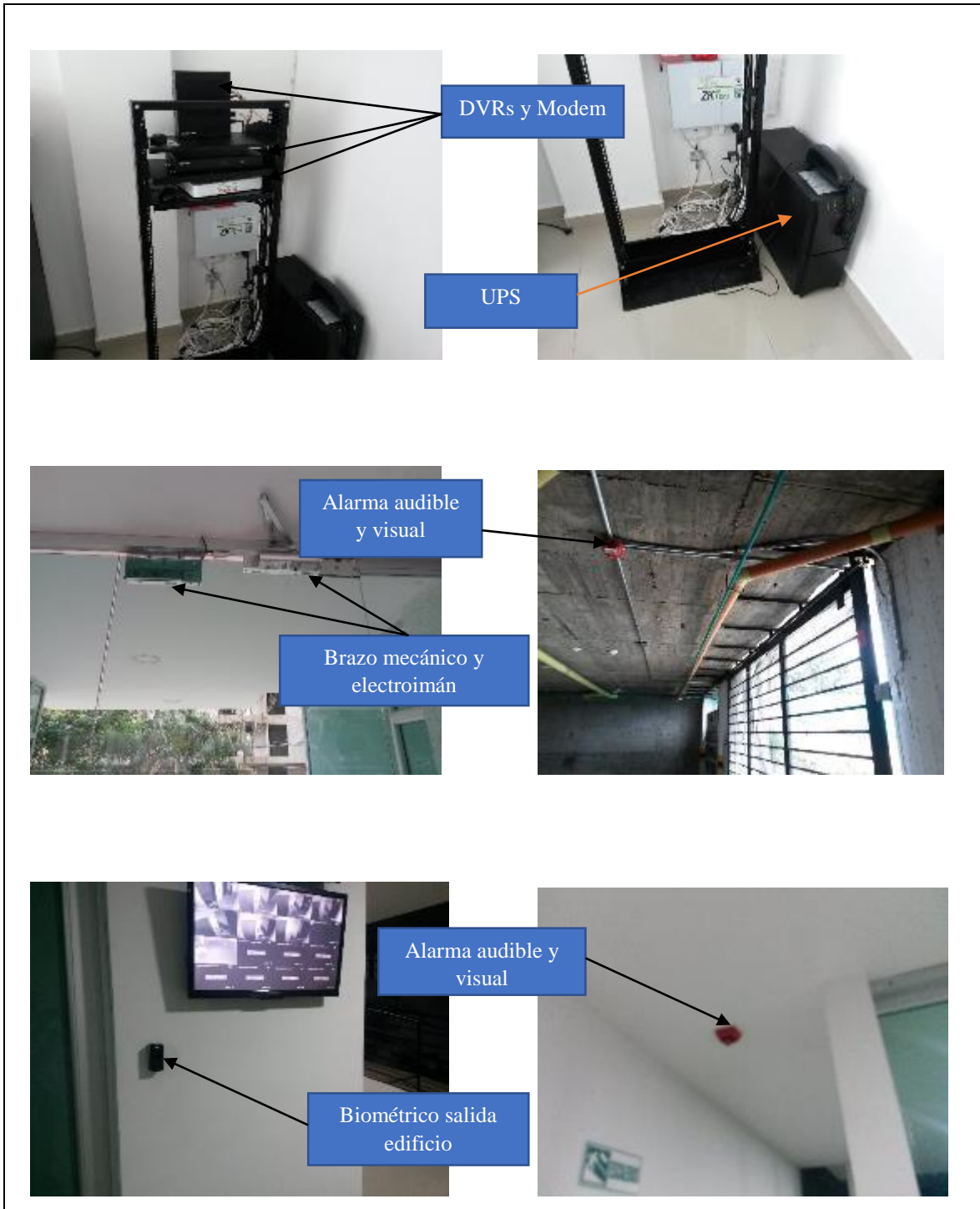
Figura 17. Dispositivos y elementos instalados
