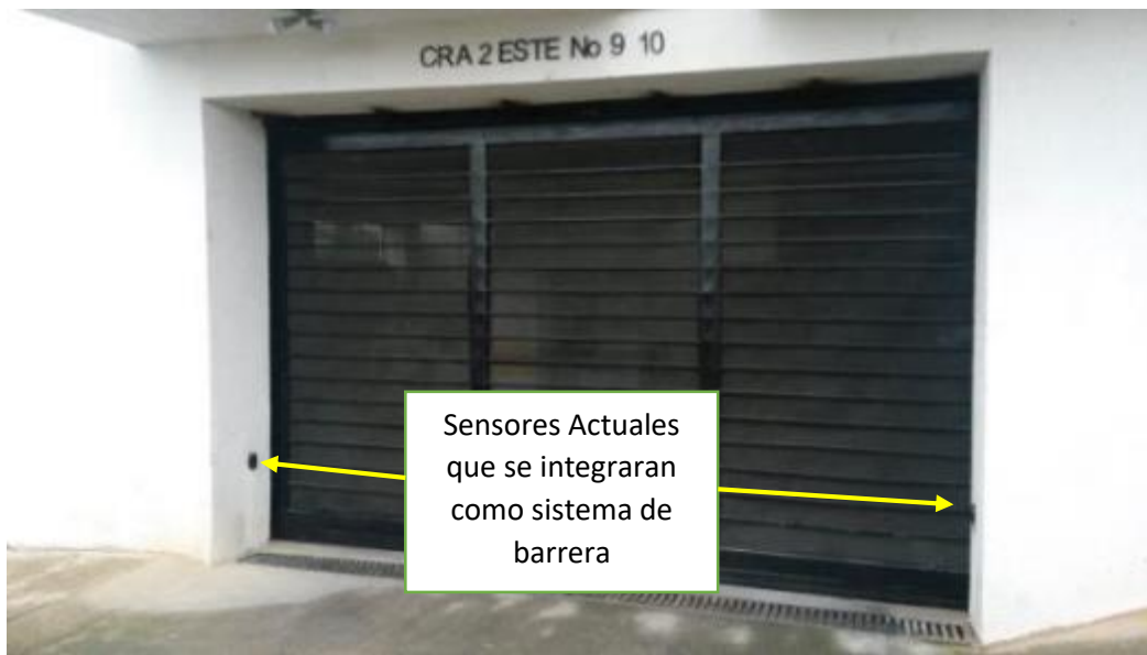
Figura 3. Componentes a integrar puerta vehicular
