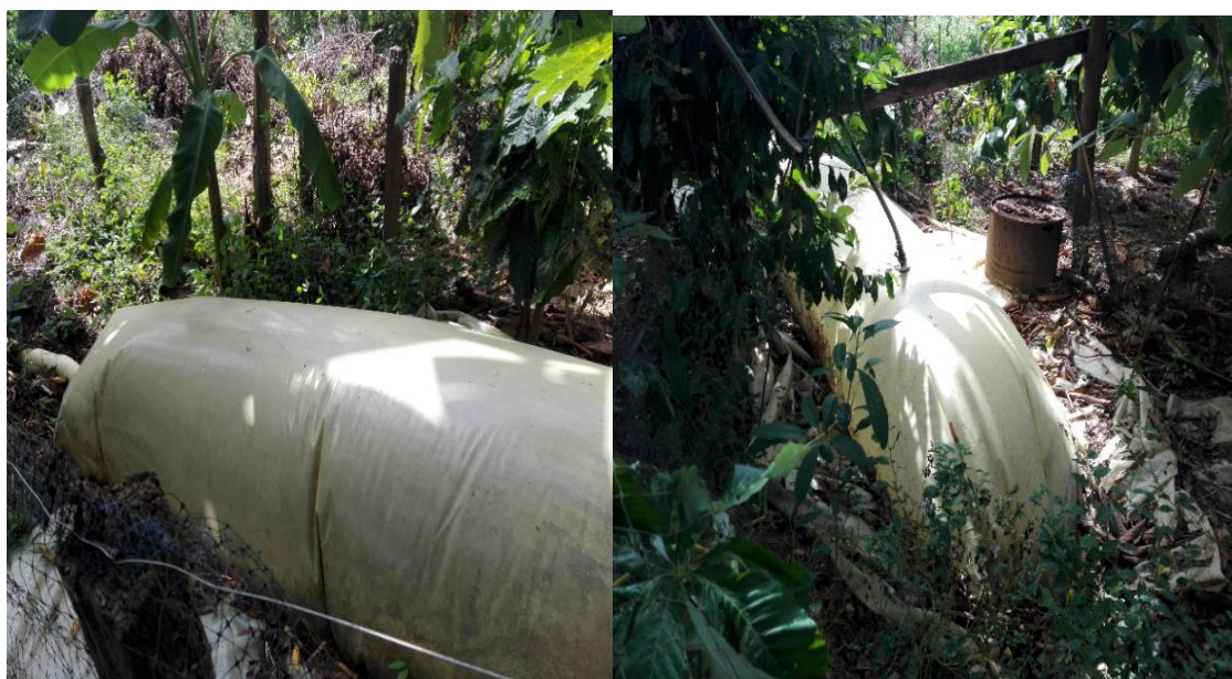
Foto 1. Biodigestor instalado en finca cerca al resguardo
