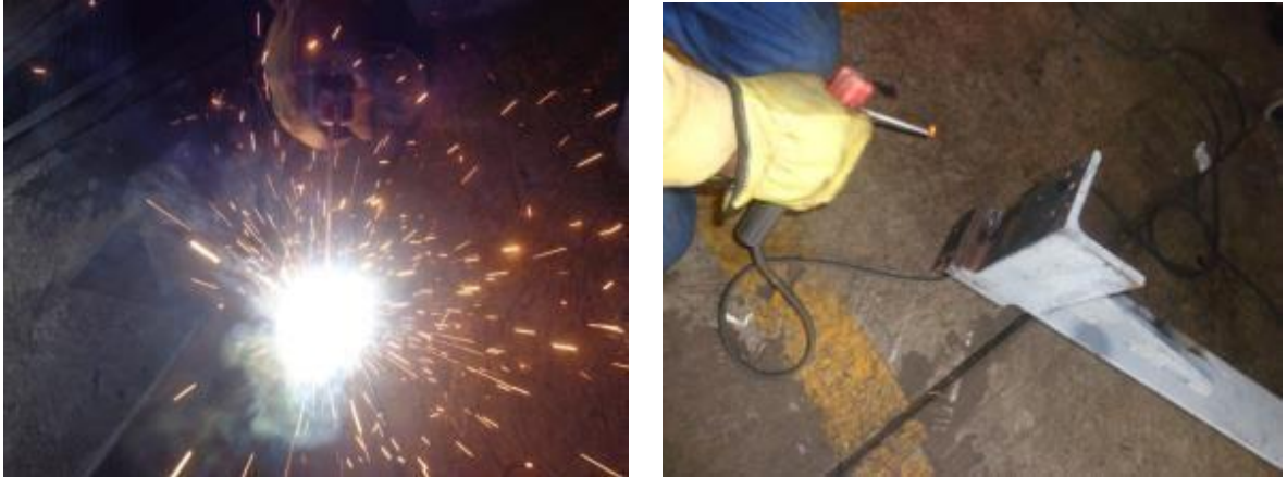
Fuente, registro fotográfico aplicación de soldadura sobre estructura metálica, autor William Ortega Lubo.
