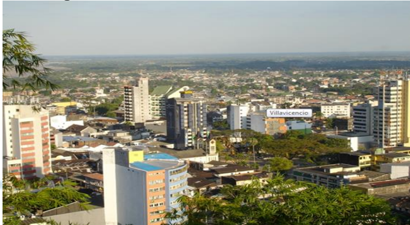
Fotografía No. 01: Panorámica de Villavicencio
