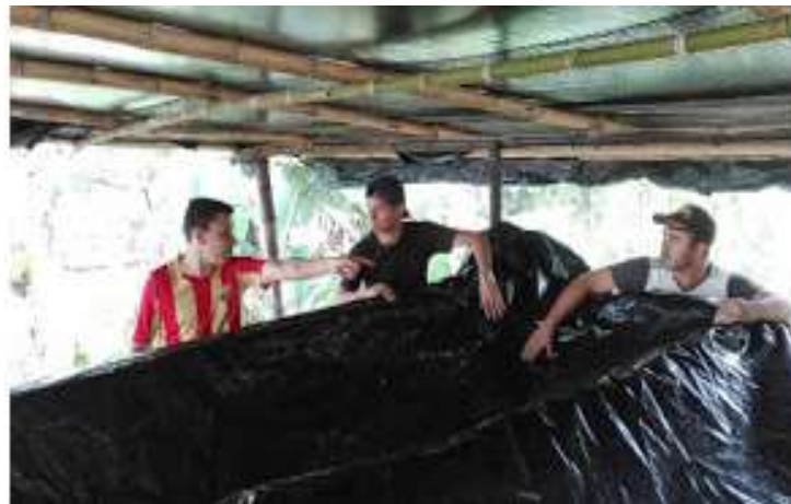
Figura 19. Construcción de las camas.
