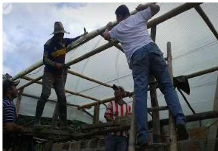
Figura 21. Construcción de la celda.
