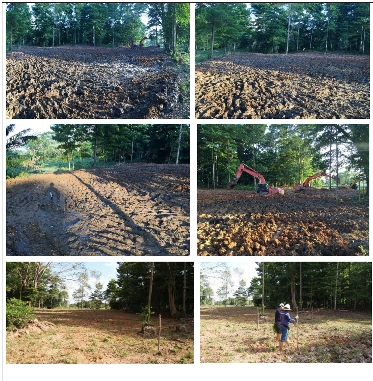
Ilustración 8. Avance de Degradación Biológica de Lodos en el Pozo Casabe 1045
