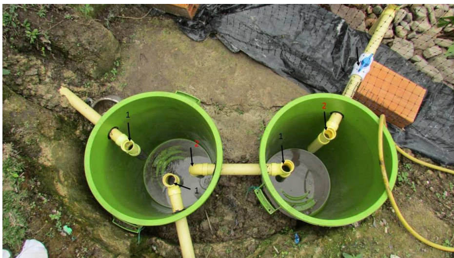
Figura 21. Diseño de trampa grasas implementado.
