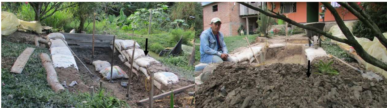
Figura 10. Proceso de Excavación.
