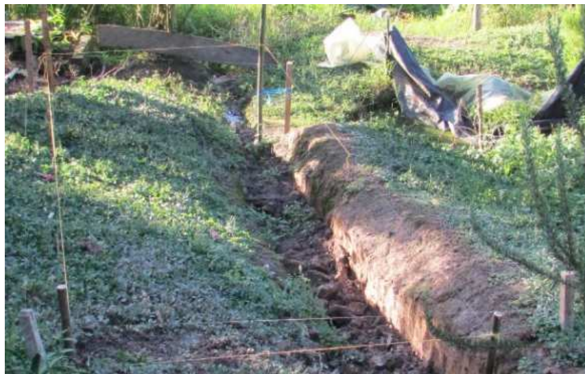
Figura 8. Área delimitada de construcción.
