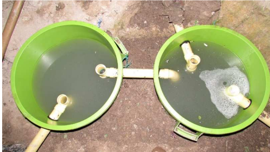
Figura 22. Funcionamiento de trampa grasas.
