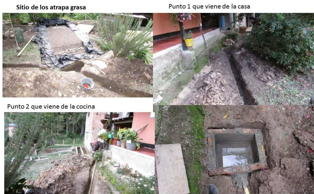
Figura 19. Adecuamiento de tubería hacia trampa grasas.
