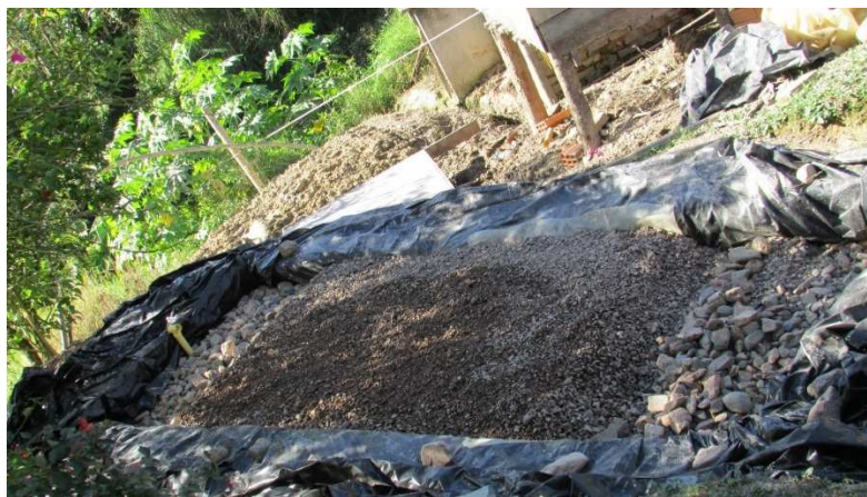
Figura 18. Finalización llenado de piedra y gravilla.
