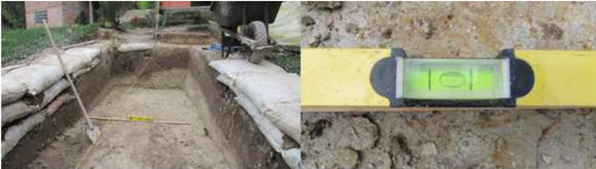
Figura 11. Verificación de Medidas y niveles de Biojardinera.
