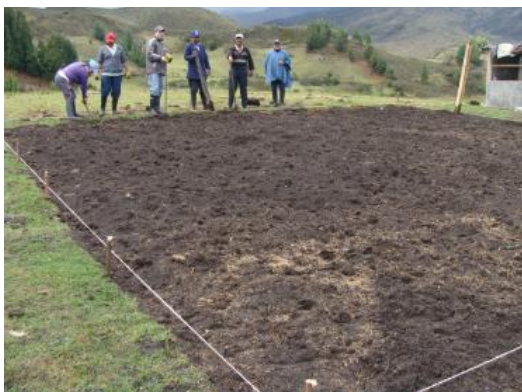
Figura 20. Actividades de preparación del terreno
