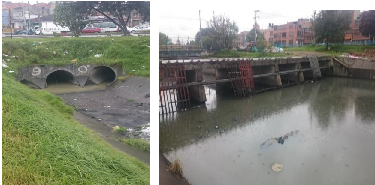
Figura 7. Puntos de inicio y final del Canal los Ángeles - Bogotá
