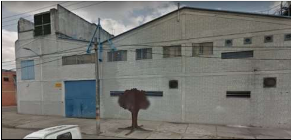
Figura 5: Planta “Proquinal S.A”
