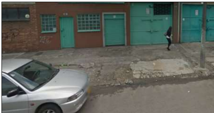
Figura 6: Fachada “Talleres HHV”
