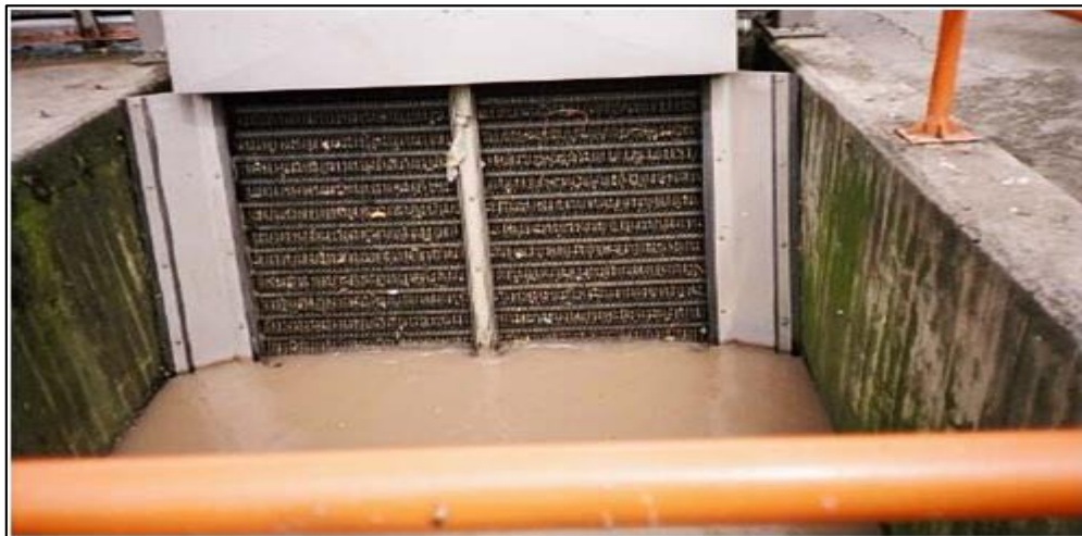
Figura 6. Cribado o desbaste de gruesos. Datos obtenidos de Satirnet (2015,p1)
