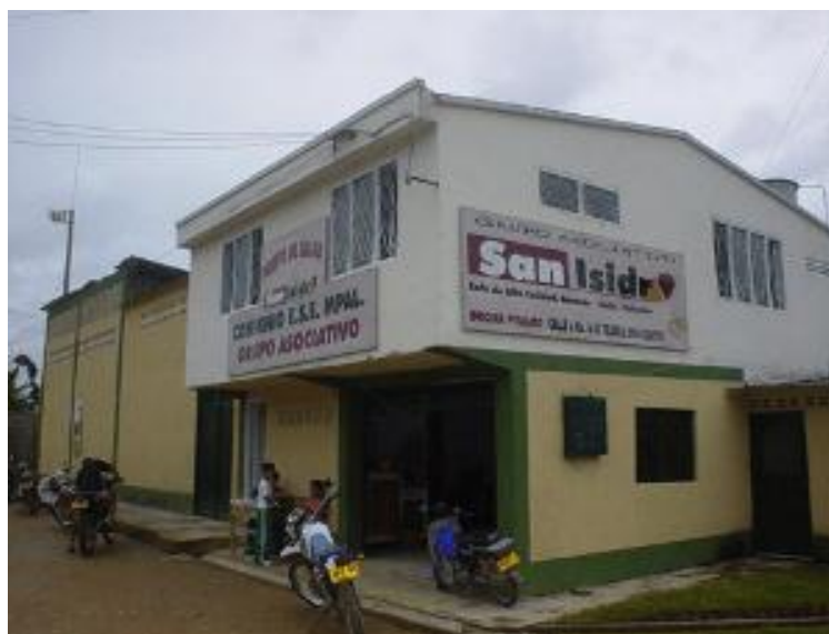
Figura 6 Sede Vereda San Isidro: fuente GASI
