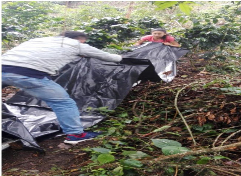
Figura 5, Instalación de plástico en los canales
