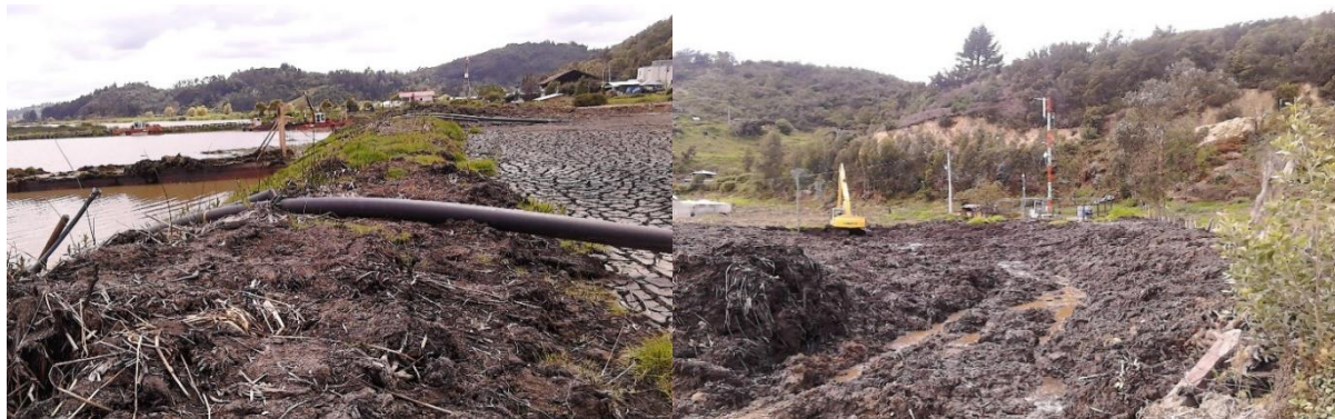
IMAGEN 16 SEDIMENTO RETIRADO DE LA LAGUNA Y LAGUNA DE LODOS. FUENTE: EL AUTOR
