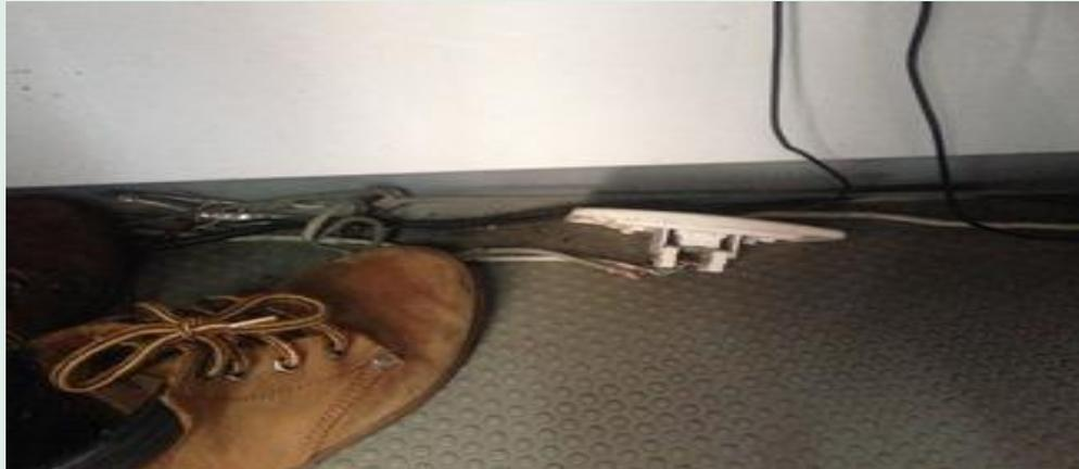
14. En revisión realizada a algunas canaletas, se logró evidenciar que no se está segmentado los ductos para el cableado eléctrico y el de voz – datos para la Zona de Postcosecha en la sede Cerezo.
