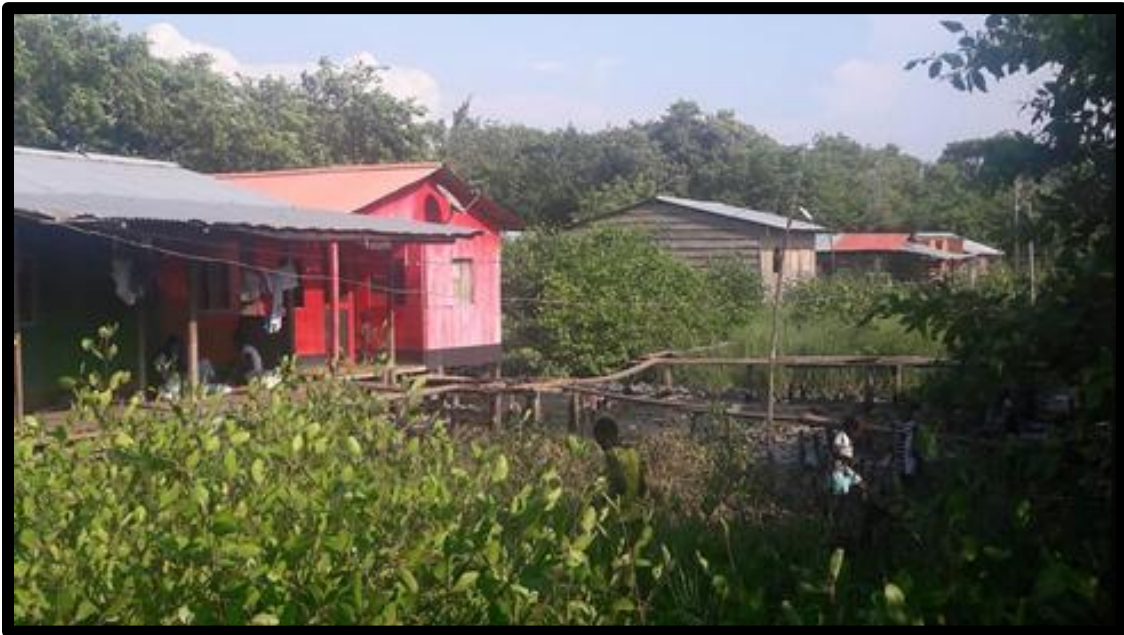
Fotografía 3 Viviendas construidas en el manglar
