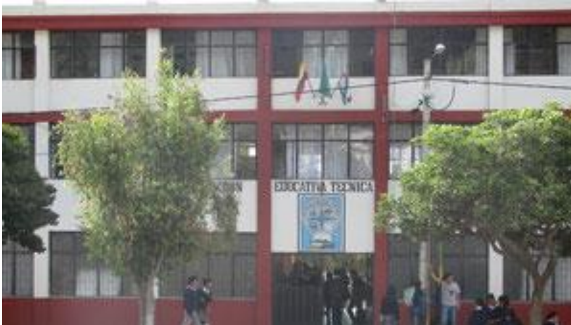
Figura 1. Fachada Colegio Técnico de Panqueba
