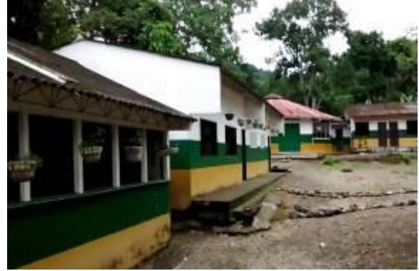
Evidencia 2. Aulas de clase de la institución.
