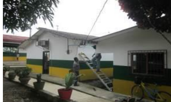
Evidencia 4. Instalación de redes de internet.
