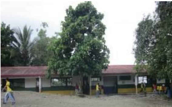
Evidencia 3. Zona de recreación
