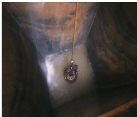
Imagen 32. Zona de Lodos.
