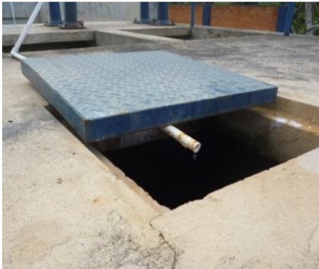
Imagen 39. Aplicación de Cloro. Fuente: Autor
