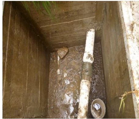
Imagen 3. Válvula de 6". Fuente: Autor
