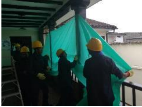
Foto 18. Demarcación áreas de trabajo. Fuente autor
