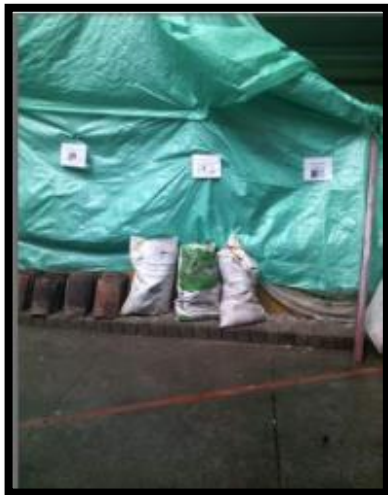
Foto 27. Cerramiento y aislamiento de RCD y materiales de construcción. Fuente autor
