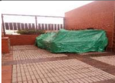
Foto 3. Clasificación y cubrimiento con polisombra de RCD. Fuente autor
