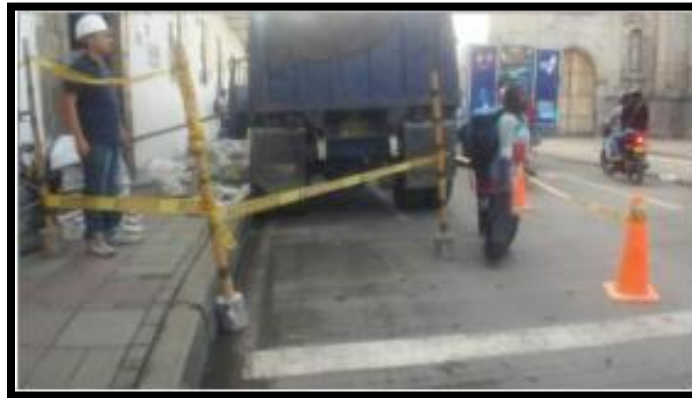
Foto 24. Cargue y retiro de RCD. Fuente autor
