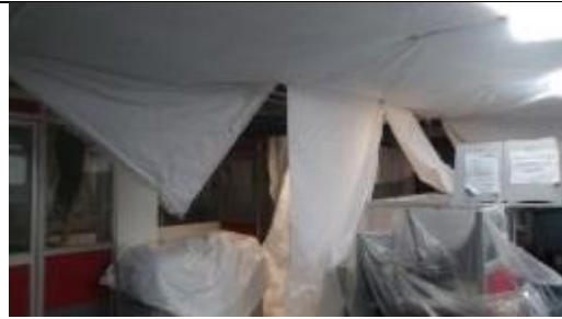
Foto 4. Protección con polietileno, mobiliario. Fuente autor
