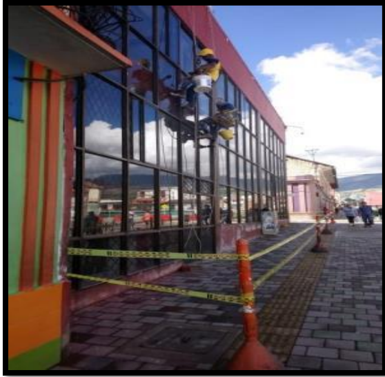
Foto 32. Verificación en el uso de EPP, línea de vida y de andamios. Fuente autor
