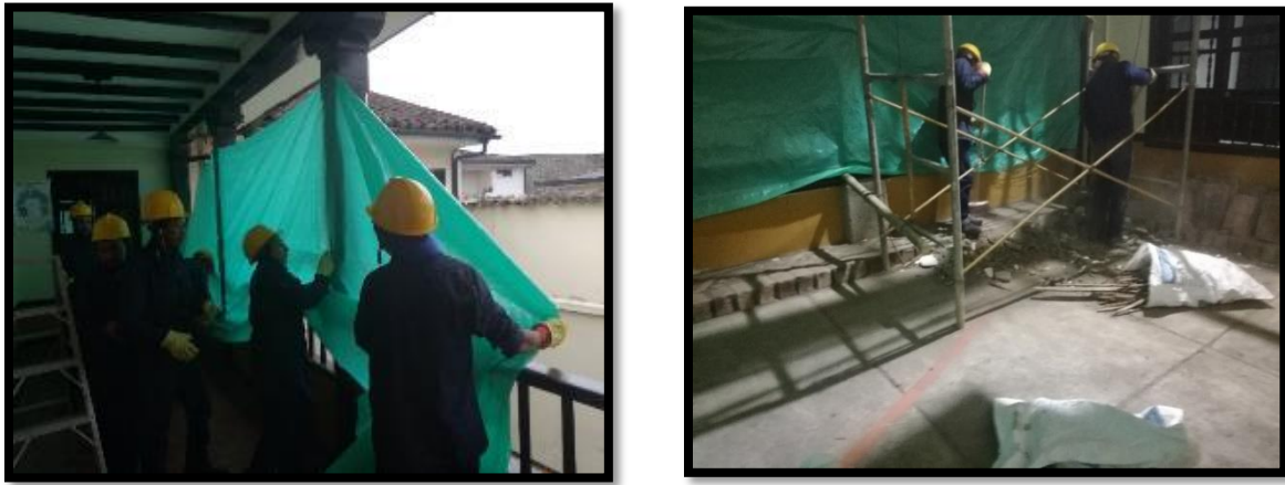
Foto 31. Cerramiento perimetral con polisombra. Fuente autor
