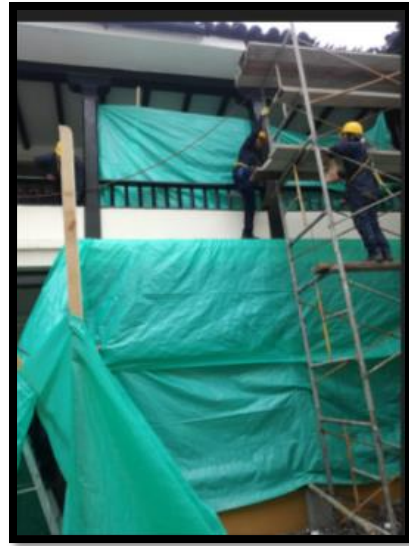
Foto 32. Verificación en el uso de EPP, línea de vida y de andamios. Fuente autor
