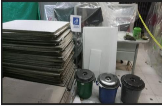
Foto 1. Acopio de material y punto ecológico de residuos. Fuente Autor
