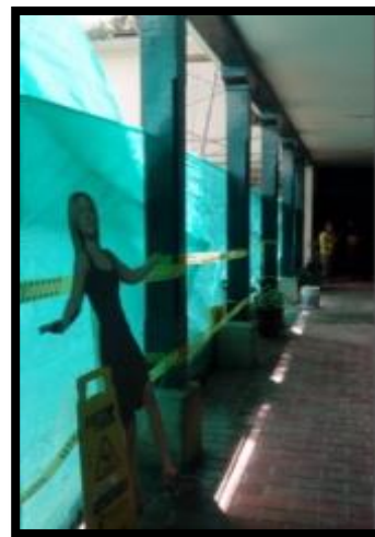
Foto 27. Cerramiento y aislamiento de RCD y materiales de construcción. Fuente autor
