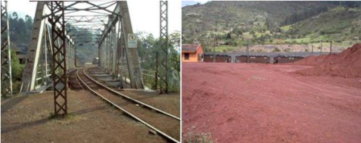
Imagen 4 (Vía Férrea Acerías Paz del Río)
