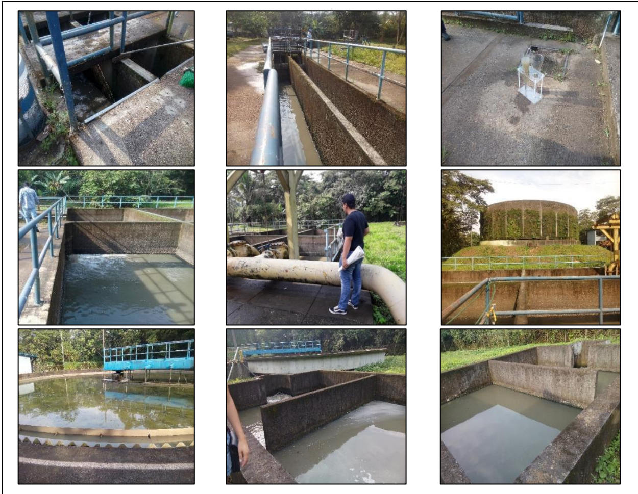
Ilustración 11. Galería de fotos de Visita a la PTAR Acacías ESPA E.S.P.
