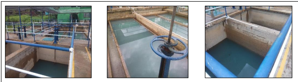
Ilustración 12. Galería de fotos de Visita a la PTAP Las Blancas ESPA E.S.P.
